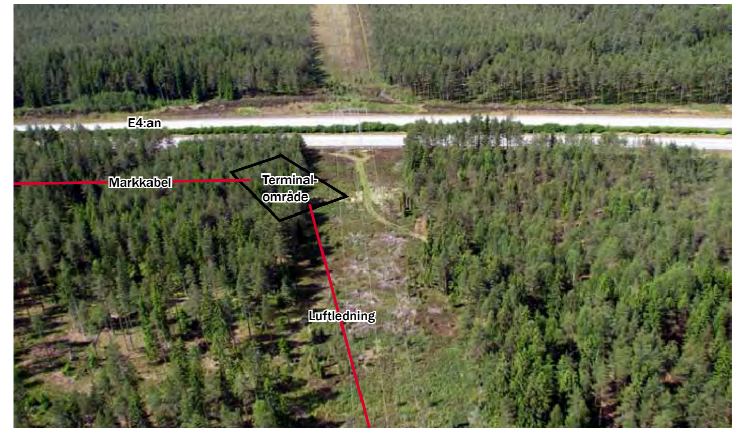
Figur 9.20 Vy mot sydväst där terminalstation planeras för anslutning mellan markkabel och luftledning. Stationen föreslås förläggas till vänster i bild hitom E4:an. Befintlig 220 kV ledning mot Värnamo rivs.
