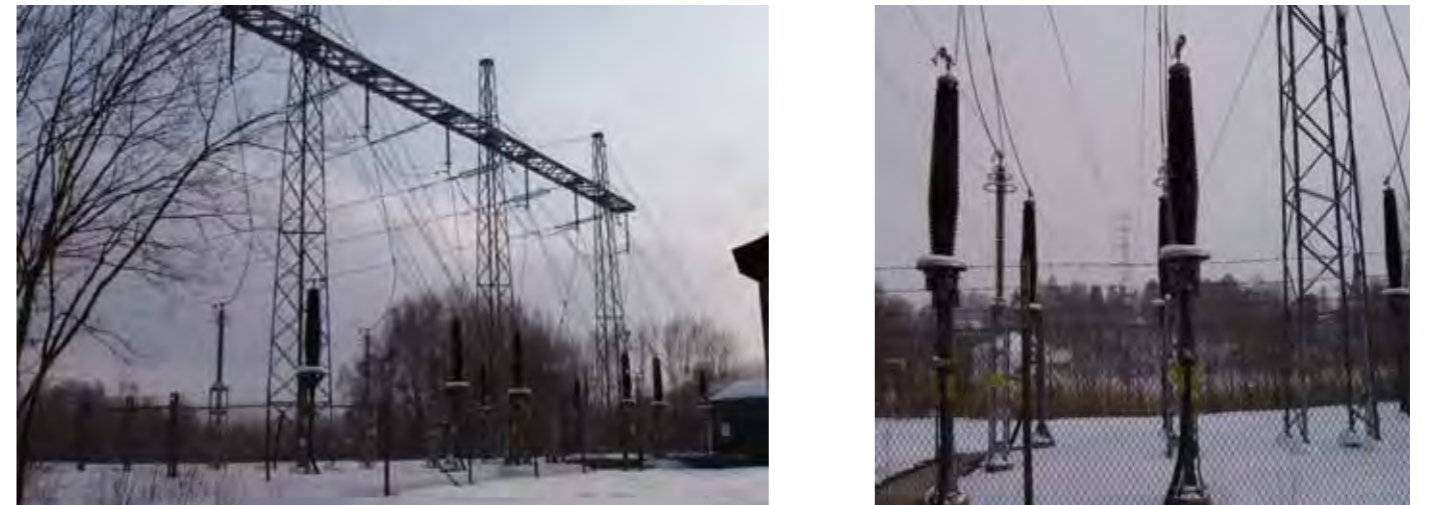
Figur 5.13 Exempel på terminalstation med kabelavslutningar och ventilavledare.
