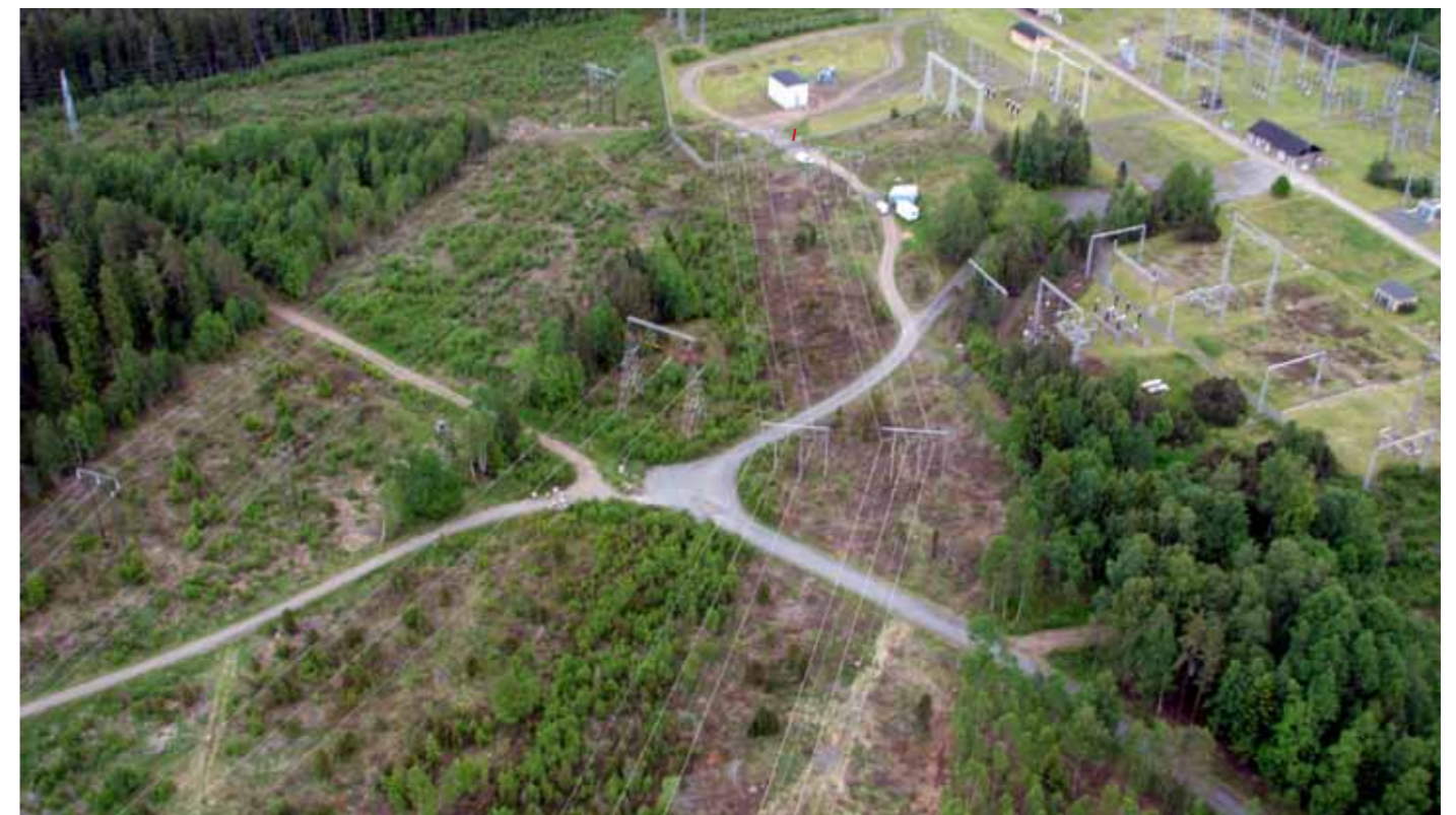
Figur 9.11 Befintligt stationsområde i Näsjö, vy mot sydöst.
