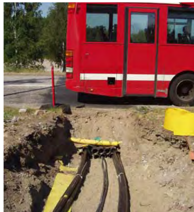
Figur 5.28 Konventionell korsning där skyddsroren förlagts i öppen schakt genom avgrävning av väg.
