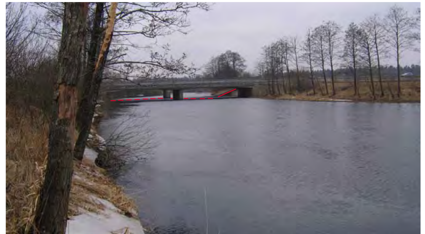
Figur 11.9 Lagan norr om Hornsborg.
