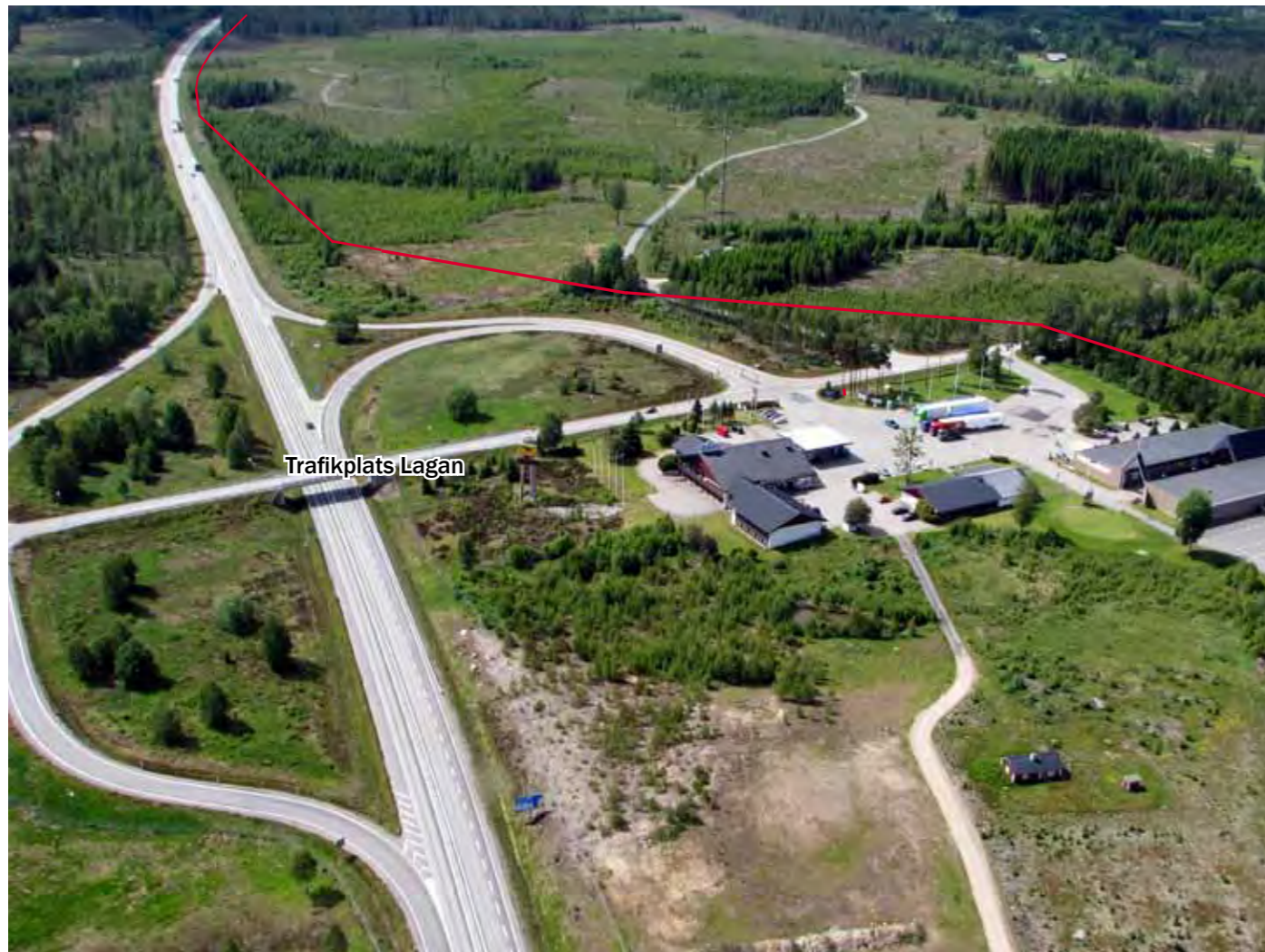
Figur 11.10 Vy mot syd vid trafikplats Lagan. Kablarna passerar väster om trafikplatsen för att undvika konflikt med framtida utbyggnad av E4:an.
