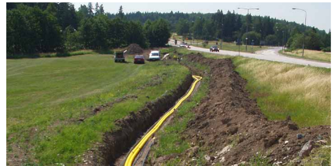
Figur 5.20 Exempel på schakt utmed väg respektive ledningsgata.
