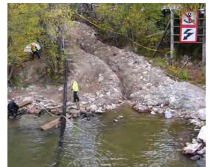
Figur 5.30 Sjökabeldike i strandkant (145 kV AC Mälaren).
