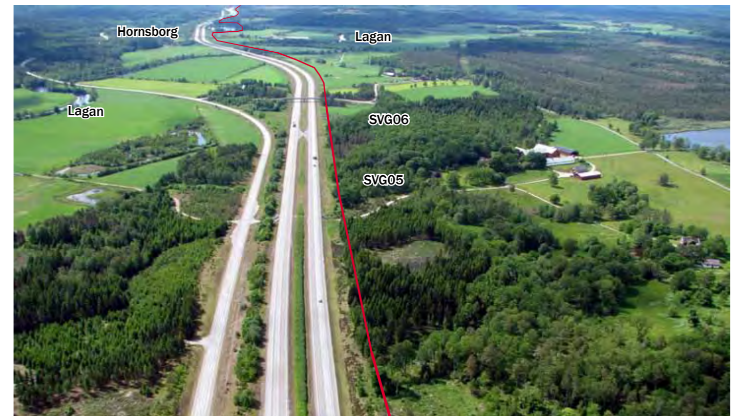
Figur 11.5 Vy mot syd längs E4:an vid Hornsborg. Utbyggnadsförslaget korsar odlingslandskapet i Lagans dalgång på vägens västra sida (till höger i bild).
