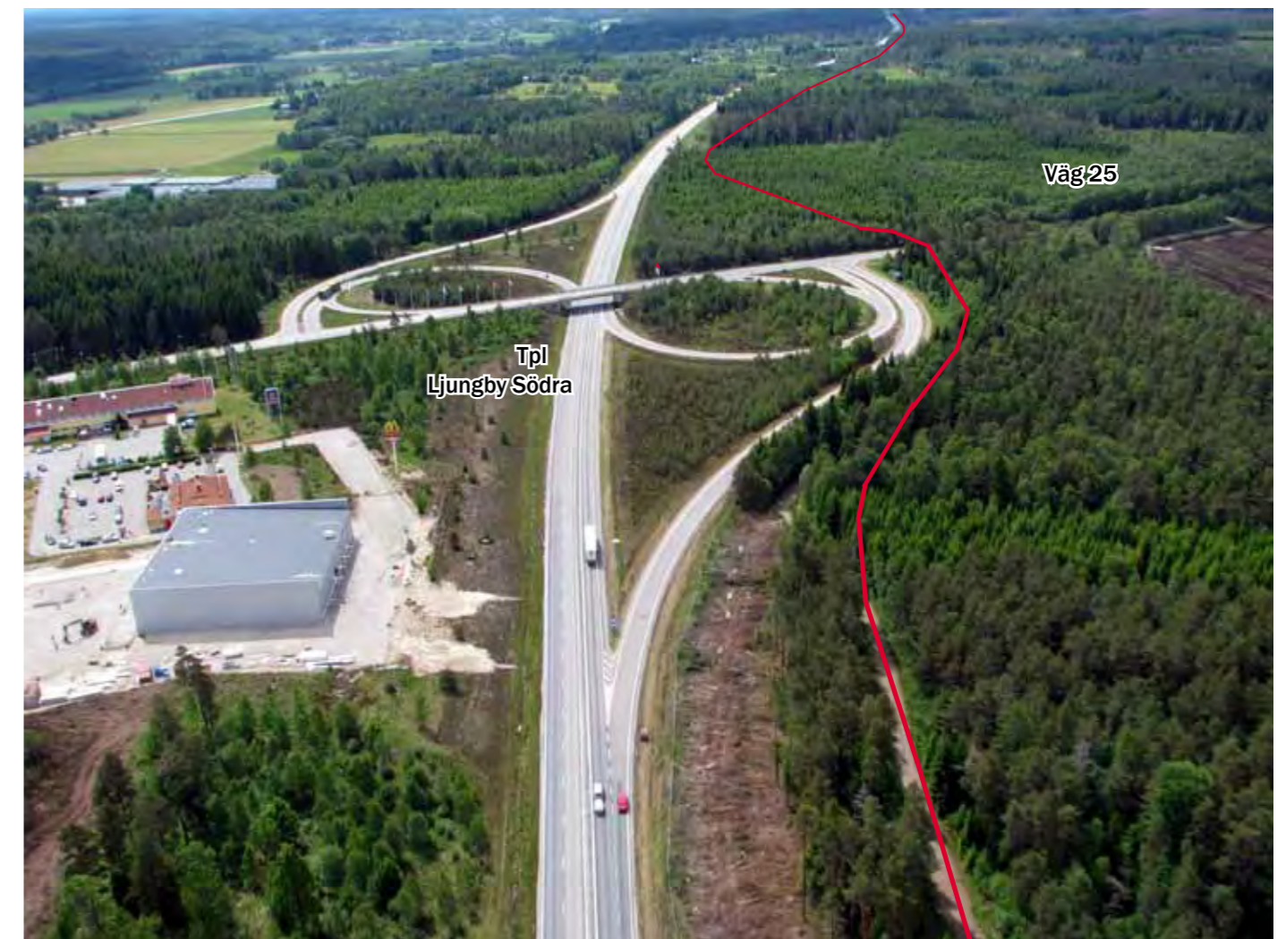
Figur 11.13 Vy mot syd vid trafikplats Ljungby Södra. Kablarna förläggs väster om trafikplatsen och med hänsyn tagen till framtida breddning av E4:an till motorväg.
