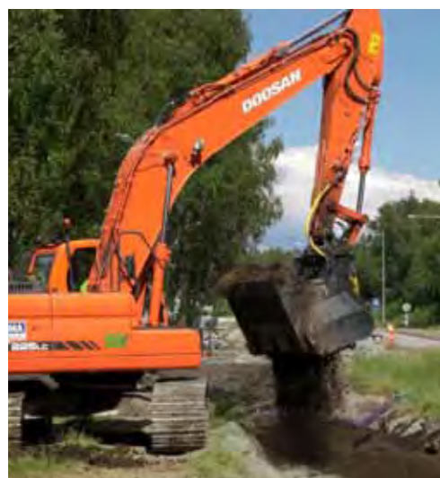
Figur 5.21 Utnyttjande av siktskopa vid arbetsplats respektive upplagsplats för massor (www.remu.se).
