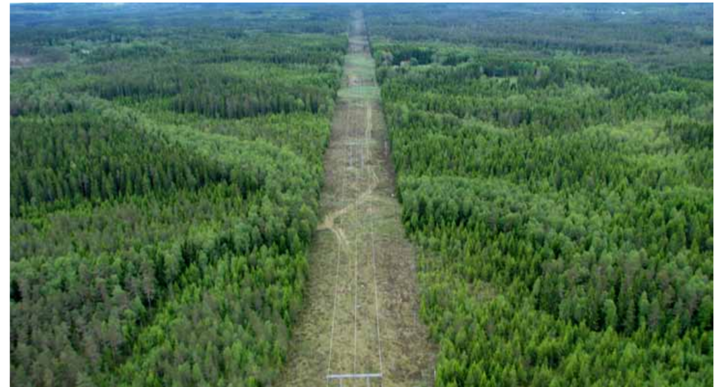
Figur 9.4 Landskapsrummet, på sträckan Nässjö-Värnamo där likkströmsförbindelsen planeras som luftledning, är i hög grad slutet i barrskogsområdena och ledningen syns huvudsakligen när man rör sig i ledningsgatan.
