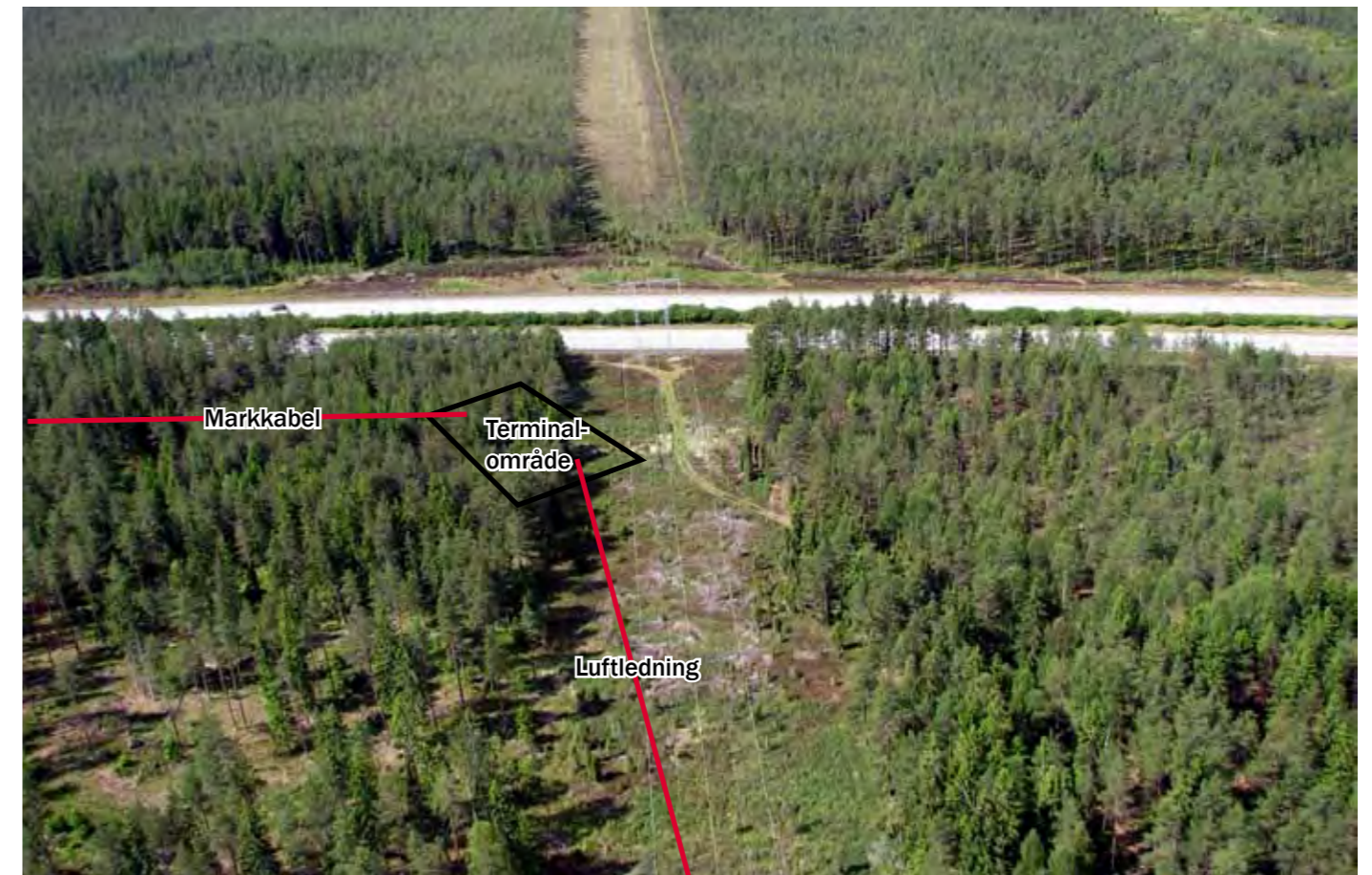
Figur 5.36 Vy mot sydväst där terminalstation planeras för anslutning mellan markkabel och luftledning. Stationen föreslås förläggas till vänster i bild hitom E4:an.
