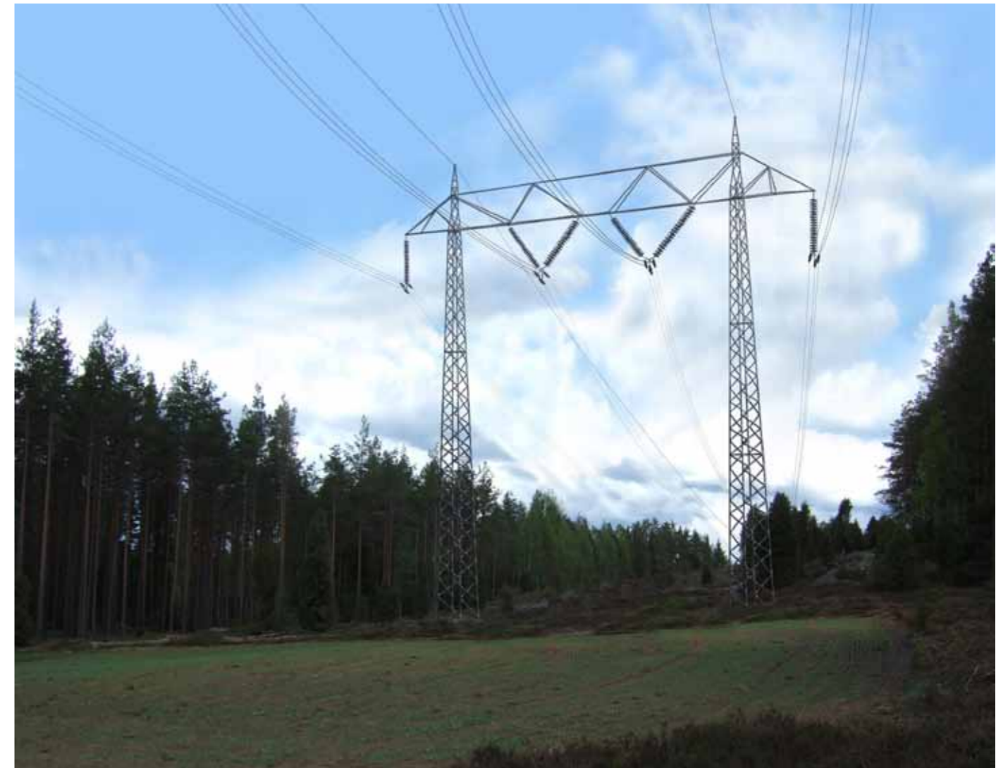
Figur 9.15 Fotomontage som visar möjlig stolputformning med 28-30 m höga portalstolpar. Med de högre stolparna blir spannlängden ca 300 m.
