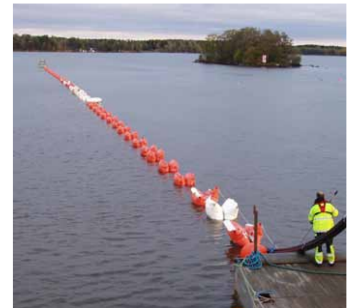
Figur 5.29 Utflottning av sjökabel.
