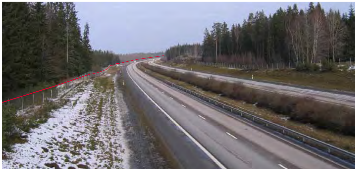
Figur 9.23 E4:an söder om Värnamo. Ledningen föreslås förläggas på den västra sidan vägen.
