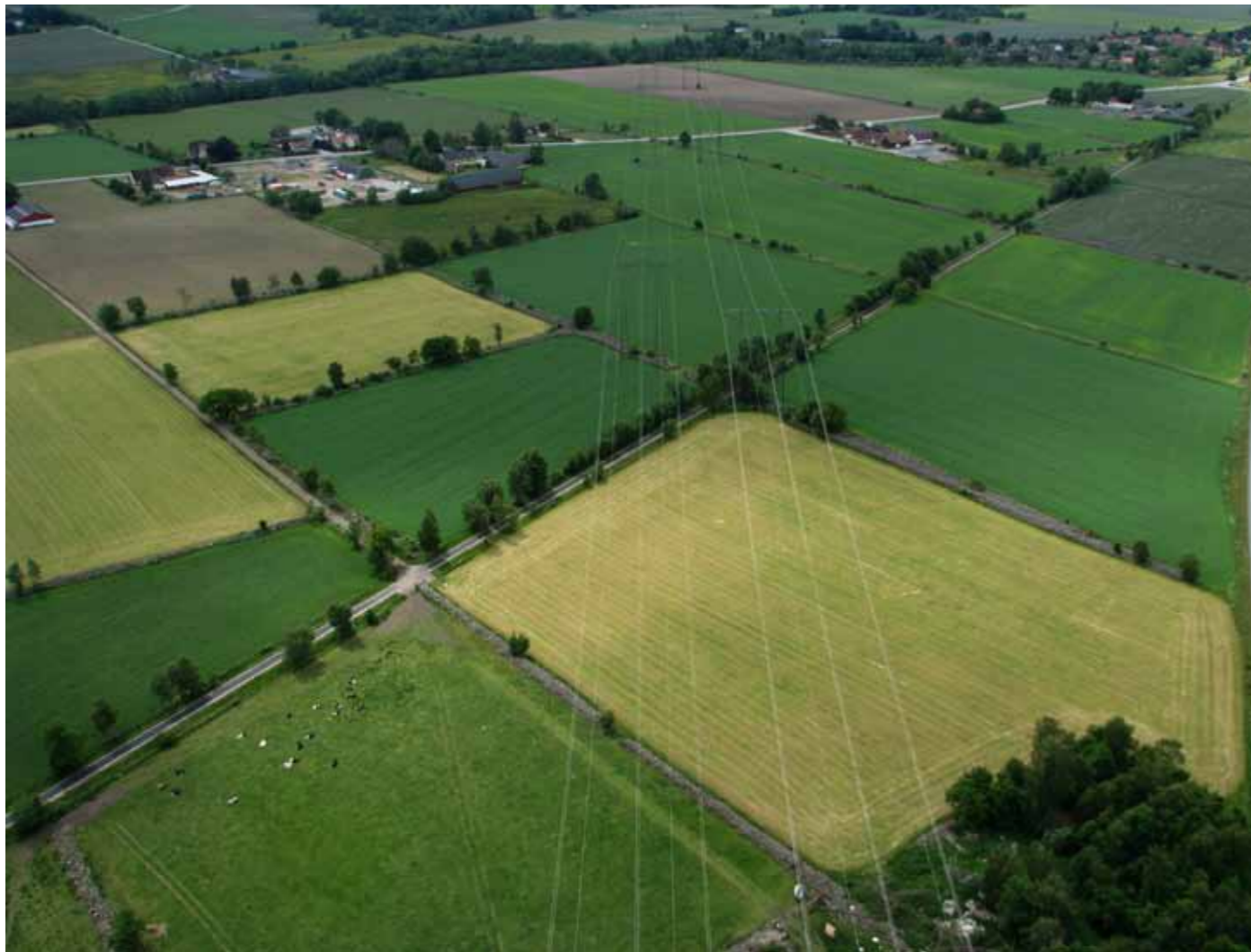
Figur 8.1 Förläggning av markkabel i ett öppet storskaligt landskap innebär begränsad påverkan utöver störning av jordbruksdriften under anläggningstiden.
