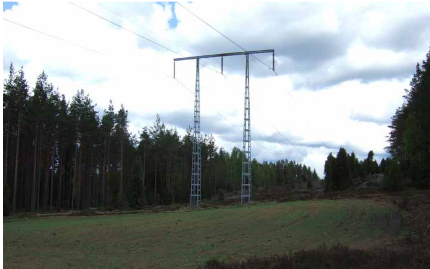
Figur 9.14 Befintliga ledningsstolpar, på sträckan Nässjö-Värnamo, är av portaltyp och ca 20 m höga. Spannlängden mellan de befintliga stolparna är 200 till 250 m.
