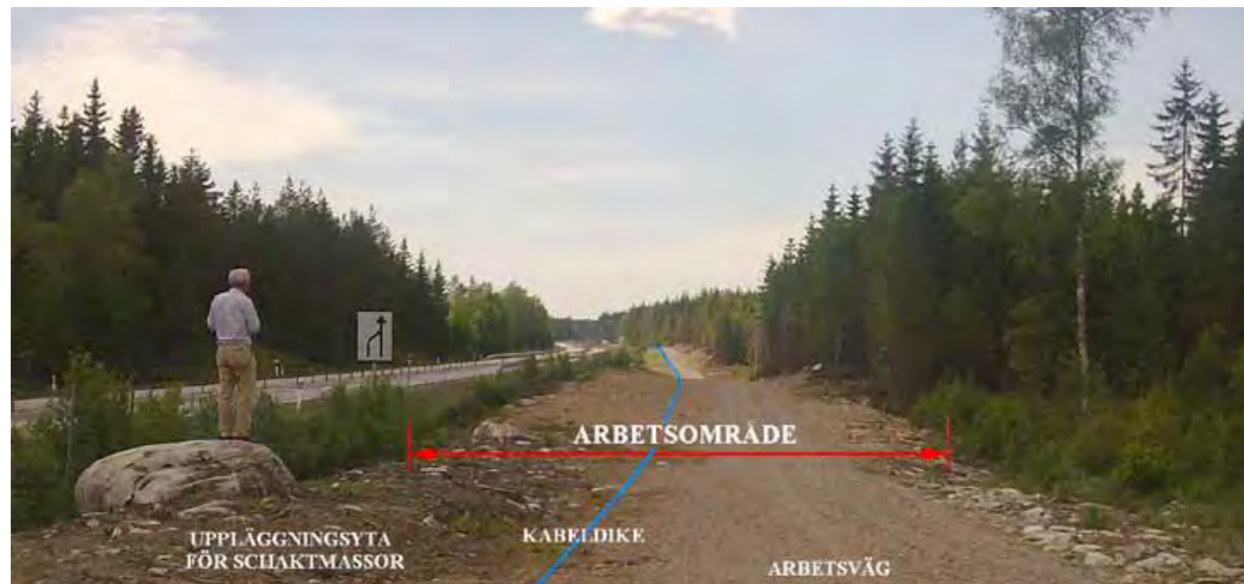
Figur 5.15 Definition av "arbetsområde" med arbetsväg, kabeldike och uppläggningssyta för massor.
