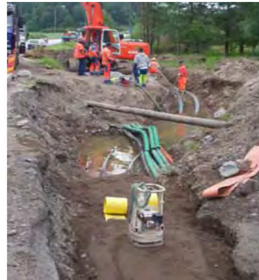
Figur 5.27 Förläggning under optokabelstråk.
