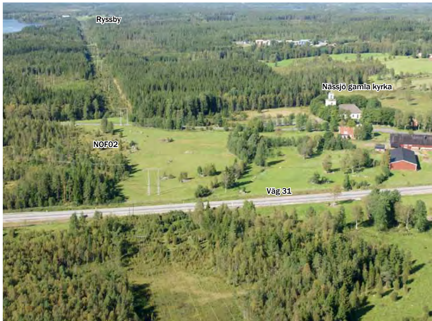
Figur 10.9 Vy mot norr, längs befintlig 130 kV ledning. Väg 31 i förgrunden, Nässjö gamla kyrka till höger i bild.
