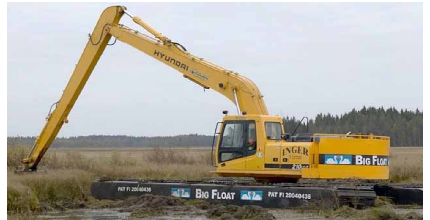
Figur 5.25 Grävmaskin med speciella pontoner för schakt i sankmark.
