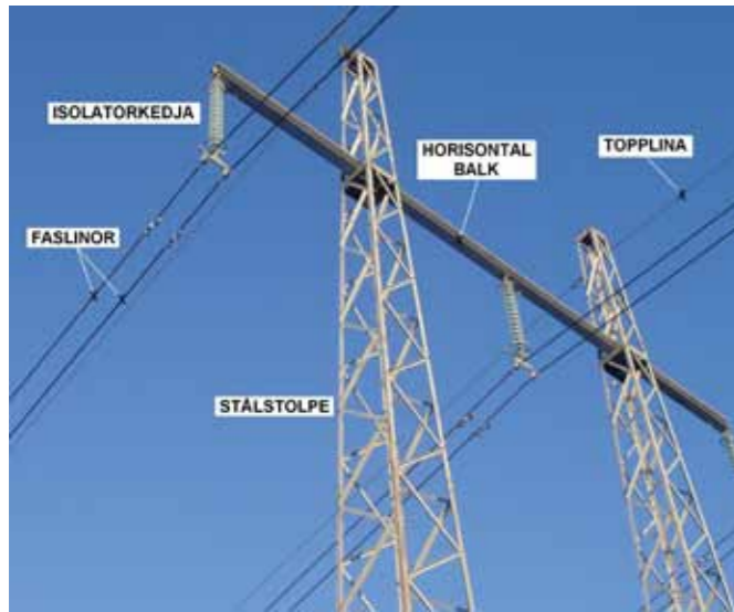
Figur 5.9 Luftledningens huvudkomponenter.
