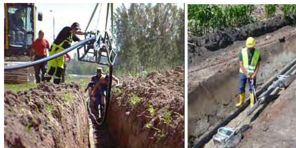
Figur 5.22 Kabelförläggning direkt ner i diket respektive på kabelrullar (www.abb.se).
