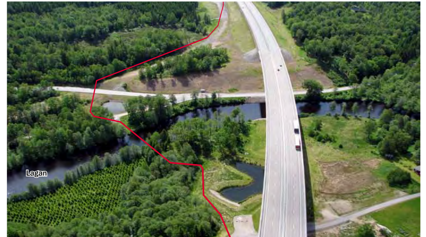
Figur 11.19 Vy mot syd. Korsning av Lagan norr om Markaryd där E4:an går på en högbro över vattendraget. Den gamla E4:ans sträckning används för förläggning på den södra dalsidan.
