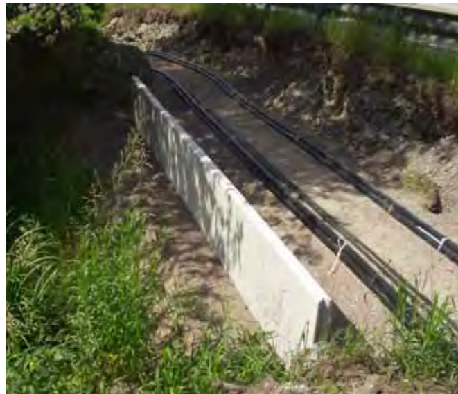
Figur 5.26 Användande av L-stöd i betong över bäck med kulvert.
