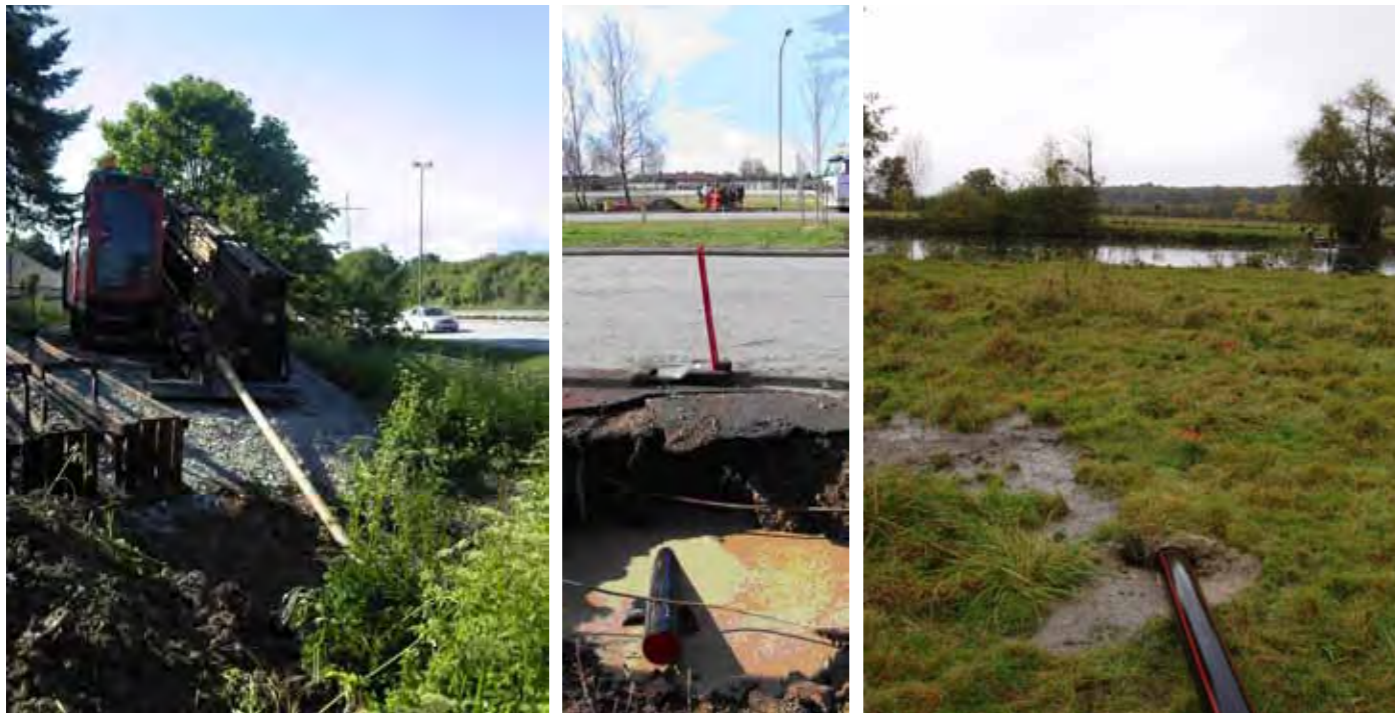
Figur 5.31 Principfigurer visande styrd borring i olika miljöer.
