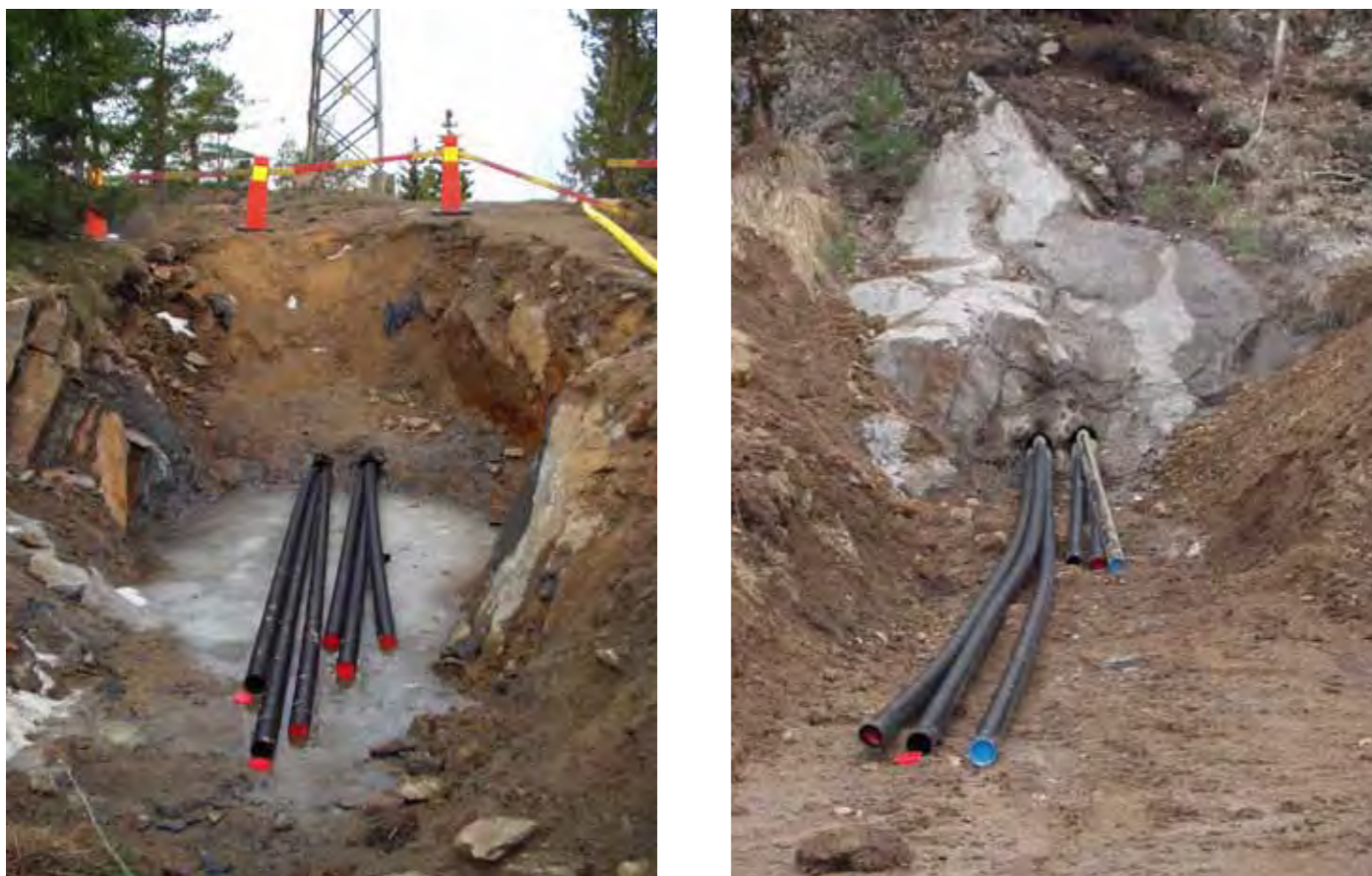
Figur 5.32 Principfigur visande berghål (fodrade med skyddsror) utförd med styrd bergsborring.
