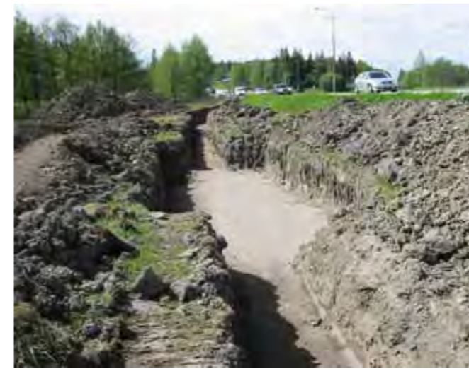
Figur 5.35 Skarvgrop för högspänningskablar.
