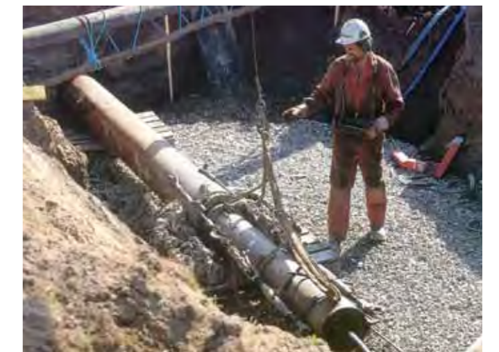
Figur 5.33 Principfigurer visande hammarborring och rörramning ("www.styrud.se").
