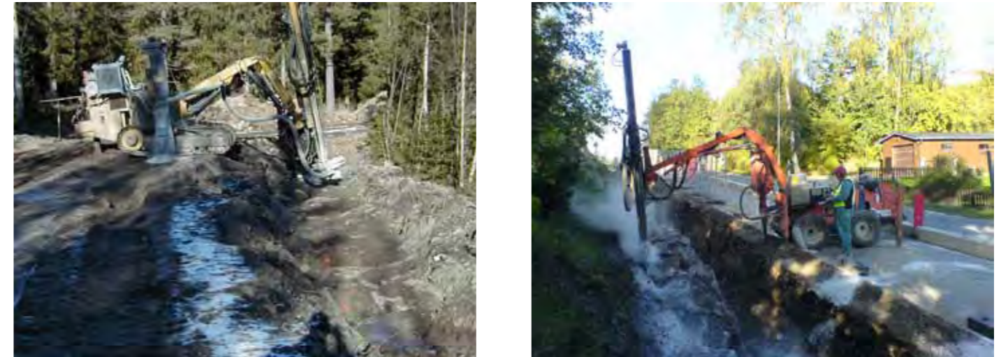
Figur 5.24 Borrhning i berg för sprängning i skogsmiljö respektive utmed väg.
