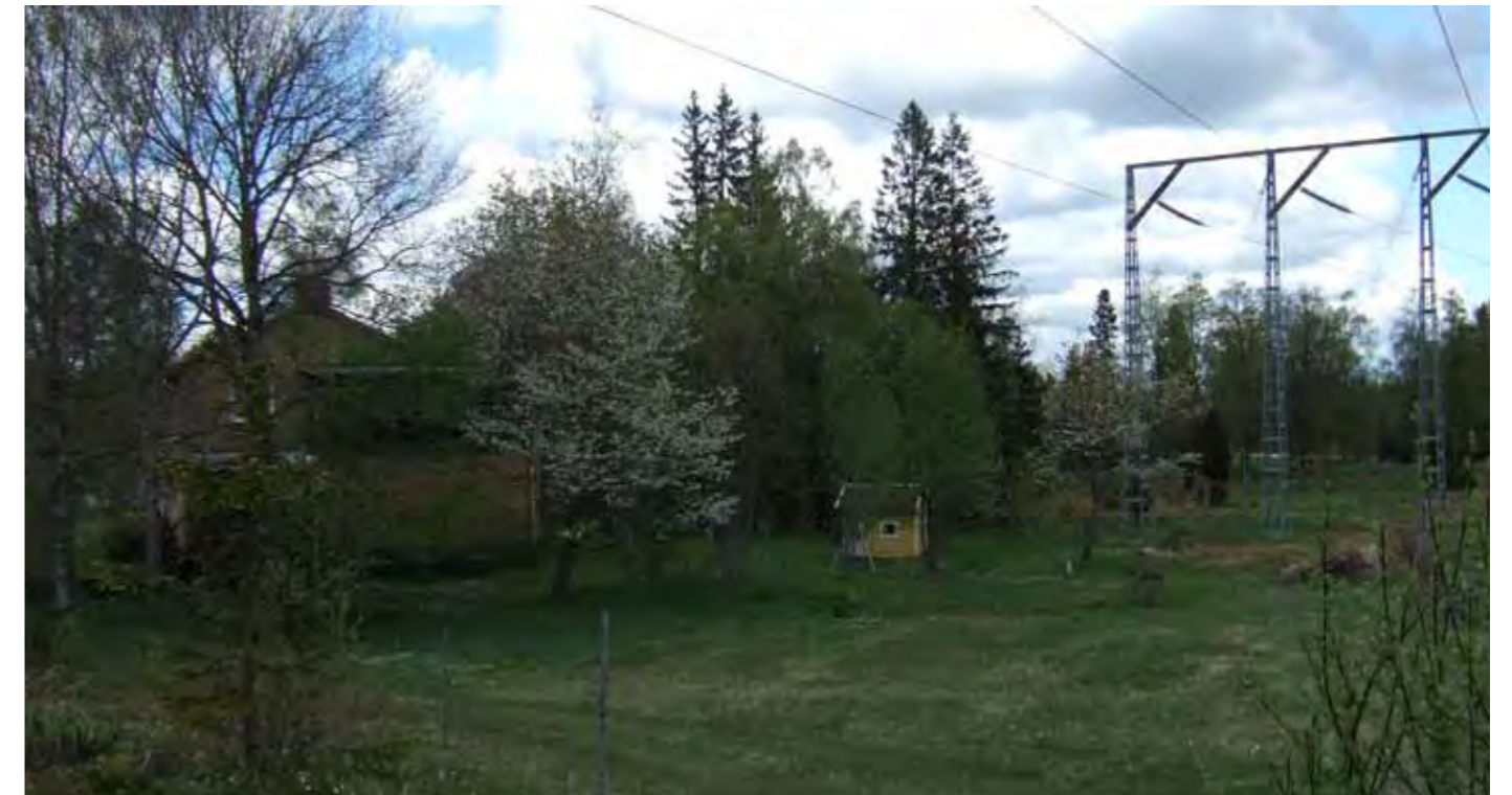
Figur 9.9 Hallhult. Befintlig hörnstolpe vid bostadsfastighet. Ny likströmsluftledning föreslås flyttas längre ifrån bostadshuset.
