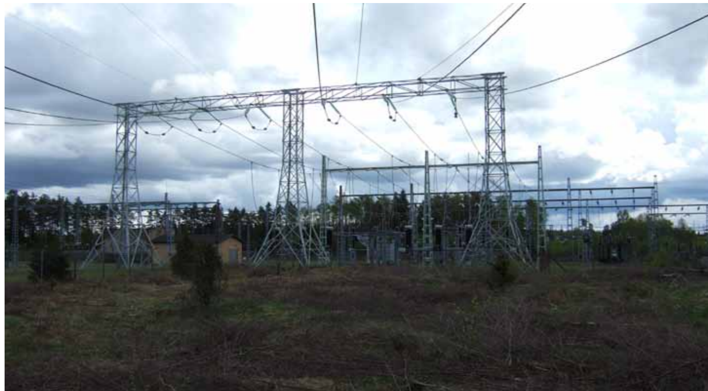
Figur 9.1 Befintlig station väster om Nässjö tätort. Ny terminalstation för övergång mellan luft och mark anläggs inom stationsområdet
