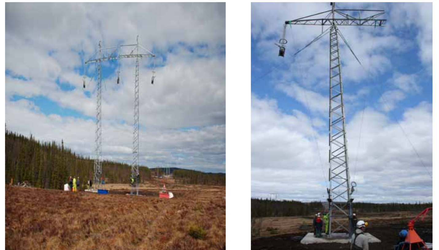
Figur 5.14 Principbilder visande resning av portalstolpe.
